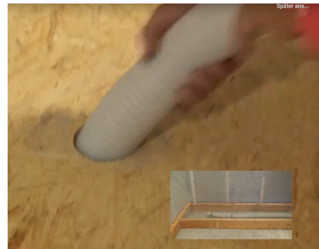
Figure 9 Mit Hilfe eines Kastens der mit einer Plexiglasplatte abgedeckt ist, kann der Einblasvorgang beobachtet und kontrolliert werden
