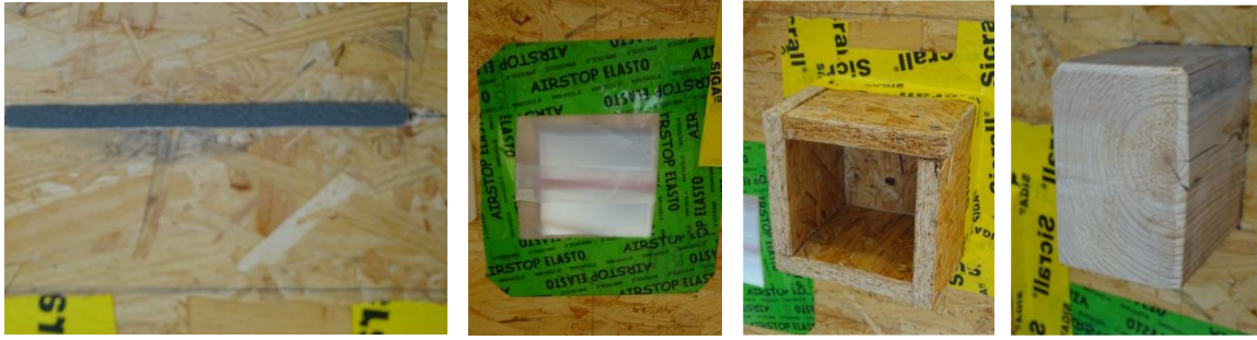
Spaltabdichtung mit Kompriband, Folienüberlappung, 3D-Abdichtung, Balkendurchführung
