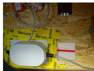
Steckdoseneinbau (links Frontansicht, rechts Rückansicht mit luftdichter Abdeckung, mitte: Hohlwanddose)
