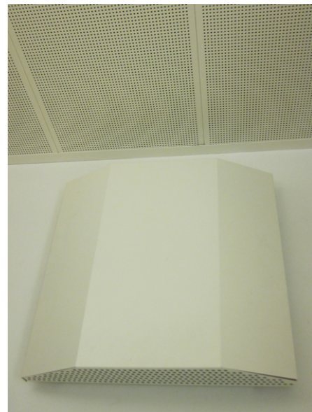
Figure 21 (Quelle: UIBK) Aktive Überströmer der Fa. Pichler Lufttechnik; Gehäuse geöffnet (links) bzw. geschlossen (rechts)
