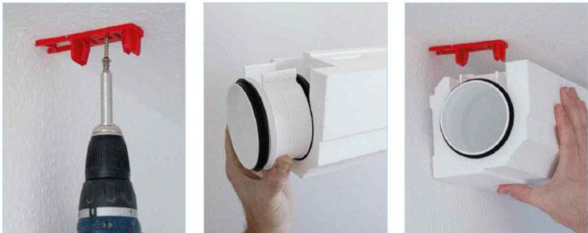
Figure 18 (Quelle: Helios RenoPipe) Montage der Befestigungs-Clips mit Deckendübel (links); luftdichte Kanalverbindung mittels Stecknippel (Mitte); Kanalmontage durch Einstecken in den Befestigungs-Clip (rechts)
