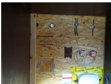
Rückseitenansicht (Innenansicht) der Kabelmontagen und Steckdosen sowie Rohrdurchführungen
