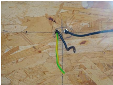
Kabel- und Rohrdurchführungen mit Manschetten
