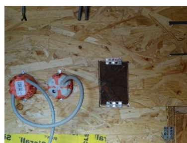
Rückseitenansicht (Innenansicht) der Kabelmontagen und Steckdosen sowie Rohrdurchführungen
