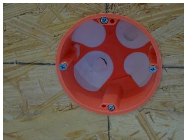
Steckdoseneinbau (links Frontansicht, rechts Rückansicht mit luftdichter Abdeckung, mitte: Hohlwanddose)
