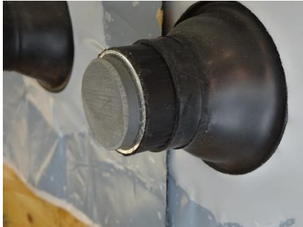
Rohrdurchführung mit Abdichtungsstopfen
