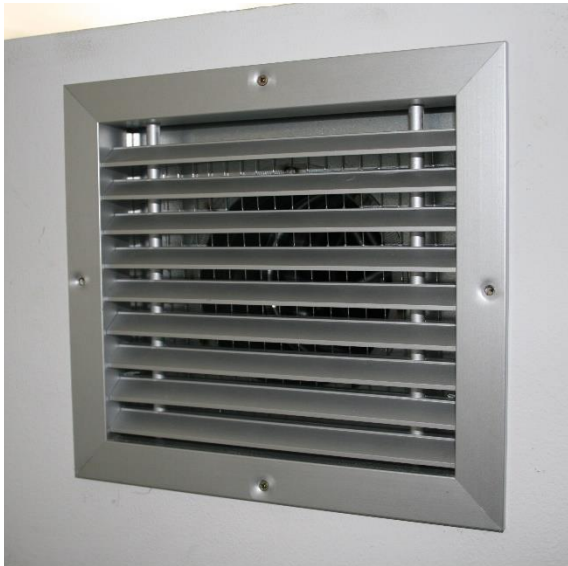
Figure 48 (Quelle: UIBK) Außen- bzw. Fortluftgitter
